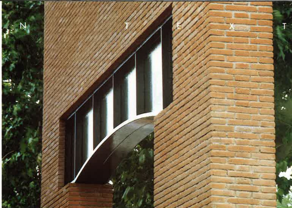
Detail voetgangersbrug in Florence
